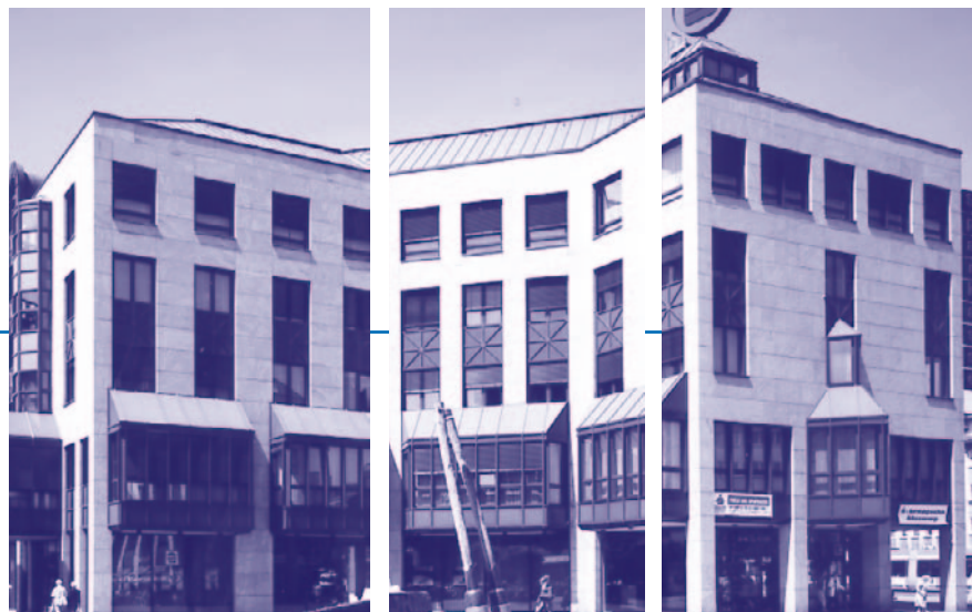
Entgegen der zumeist teureren Empfehlung der Rechenzentren entschied sich die Sparkasse Mülheim an der Ruhr bei der Einrichtung ihrer neuen IT-Infrastruktur für aktive Komponenten von 3Com – einen SuperStack 3 Switch 4900 SX im Core und mehr als 40 Etagenverteiler der SuperStack 3 4400-Familie.
